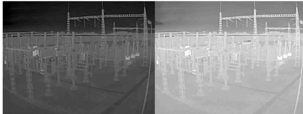
**Schärfe:** Stellen mithilfe des Schiebereglers den Randkontrast ein, um Objekte in einem Bild schärfer darzustellen. Wenn Sie die Schärfe erhöhen, kann dies zu einer höheren Bitrate und einem höheren Bedarf an Speicherplatz führen.
